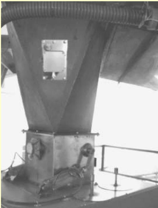
Рис. 4.2. Пример установки СВЧ-датчика влагомера «Микрорадар-114Р»
