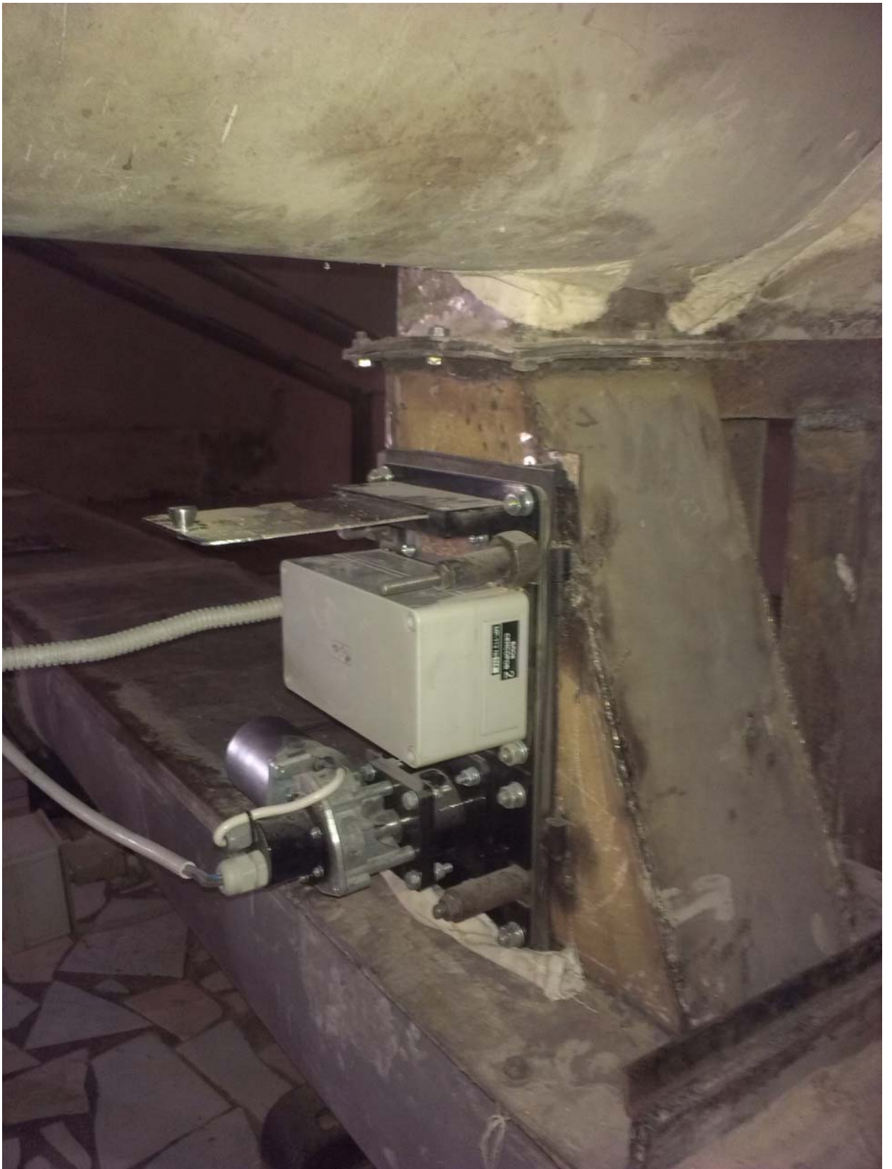
Крупный план: фото установки влагомера на конусе выхода из БШУ
