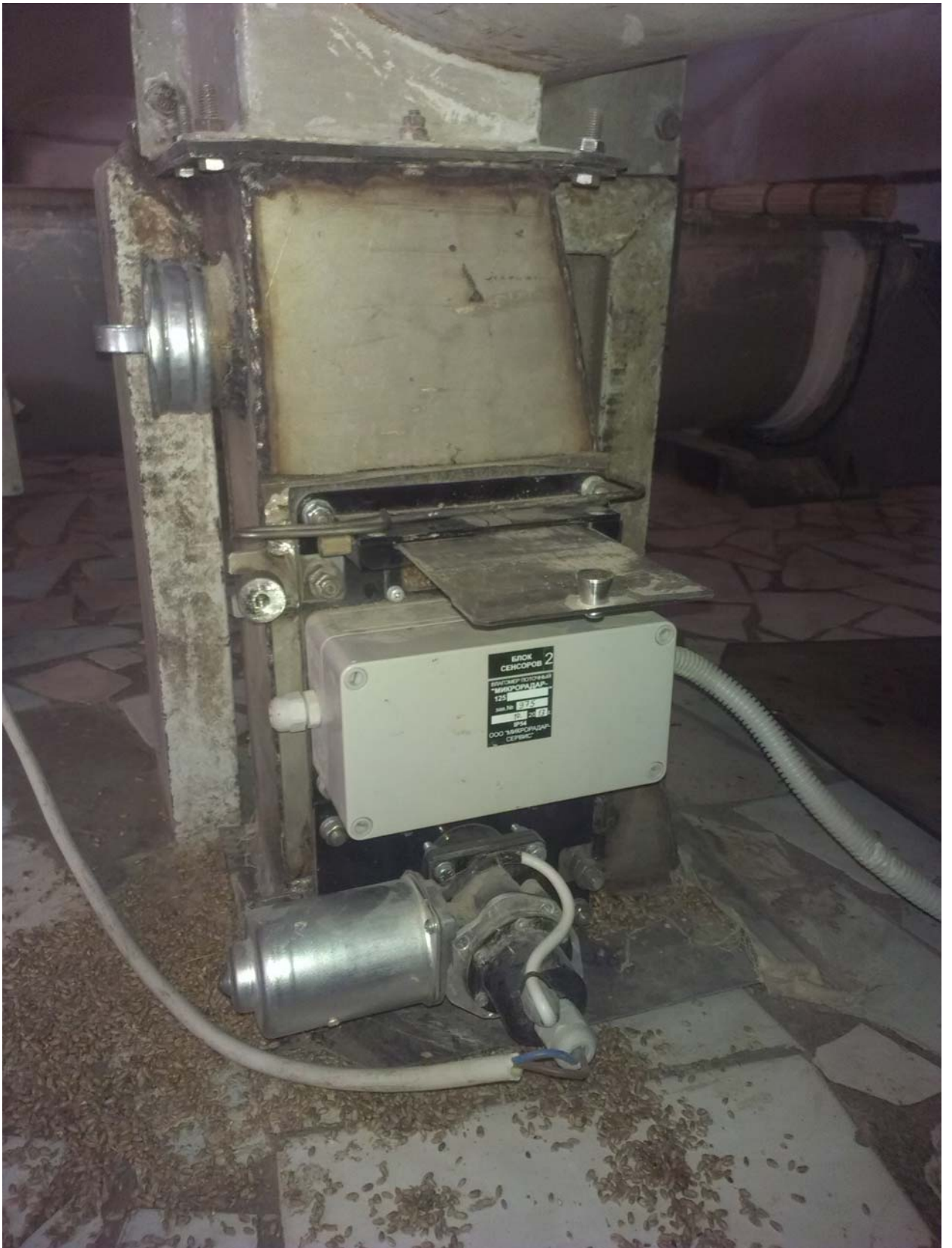
Крупный план: фото установки влагомера в зернотоке на выходе из БШУ.
